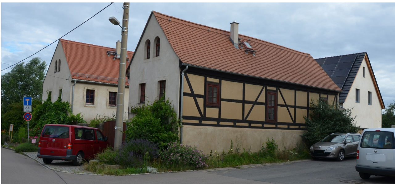
Abbildung 1: Ansicht Fachwerkhaus (Auszugshaus mit beschriebener Wohnung) vom Dorfplatz
